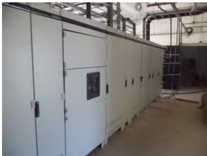
PRÉDIO DE UTILIDADES – CENTRAL ELÉTRICA – 19/11/2013
