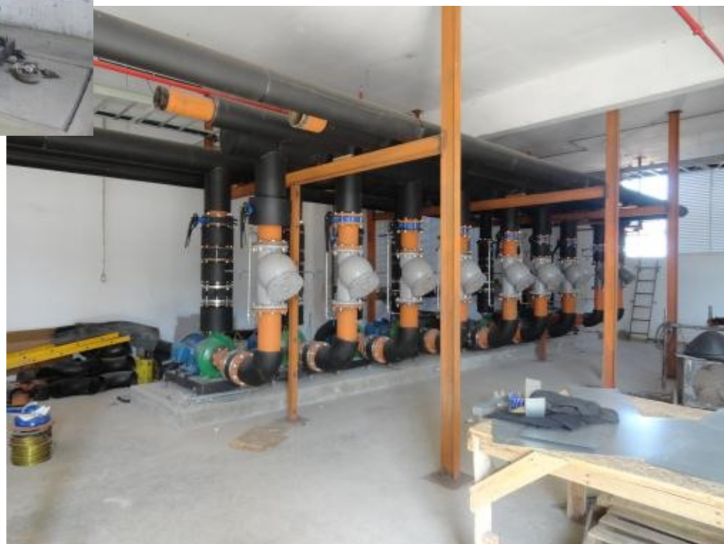
PRÉDIO DE UTILIDADES – MONTAGEM CENTRAL DE ÁGUA GELADA
