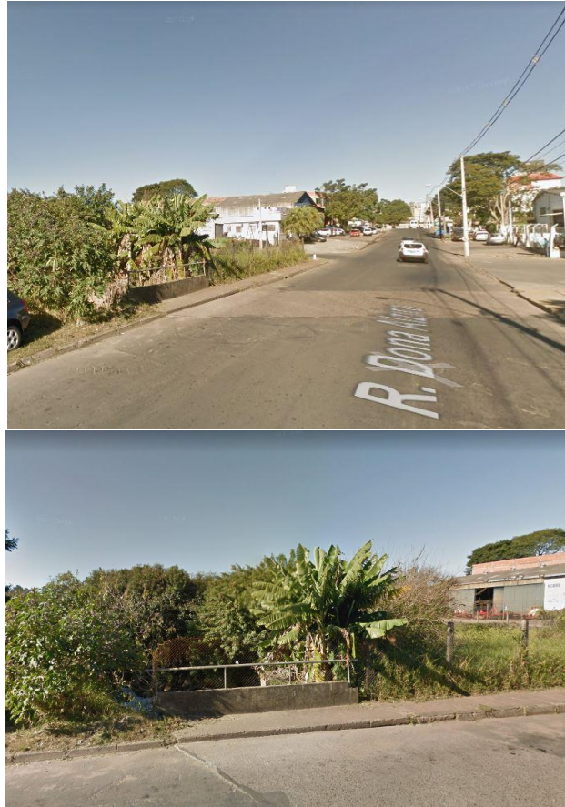
Travessia 1 – Rua Dona Alzira sobre o Arroio Mangueira
