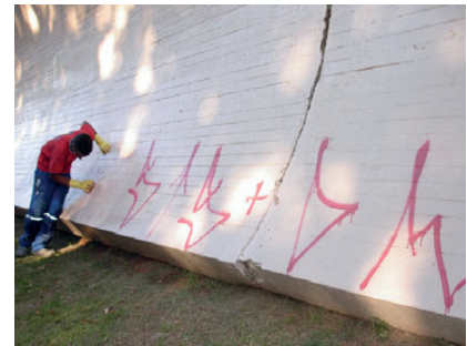
(e) limpeza de viadutos
