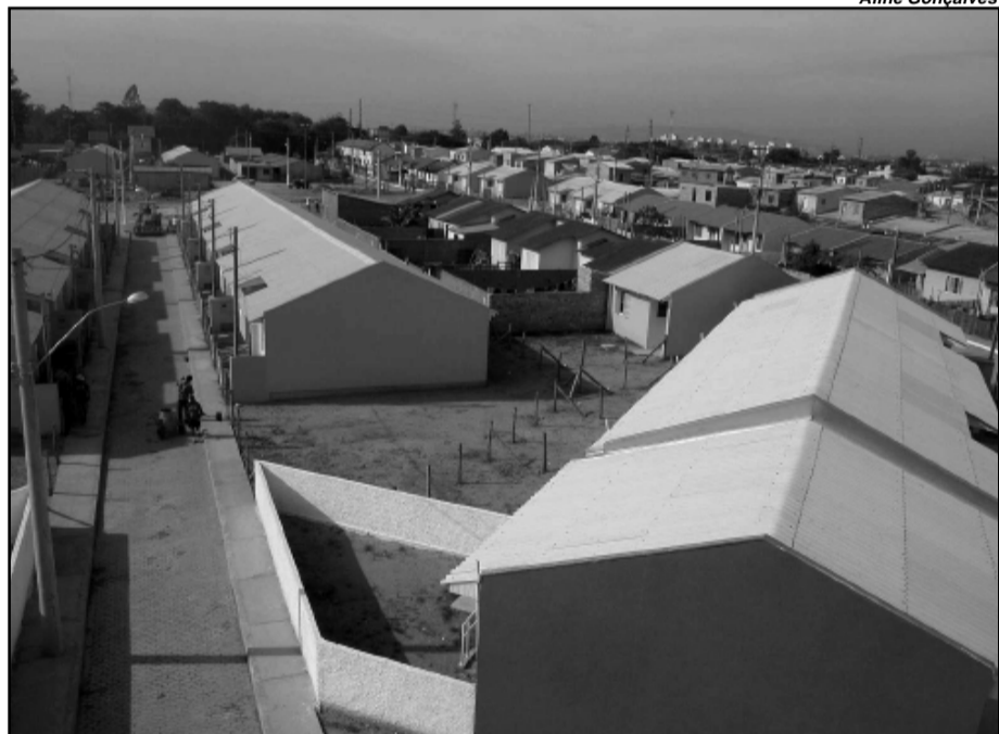
Obras que estão mudando a paisagem da entrada da cidade
