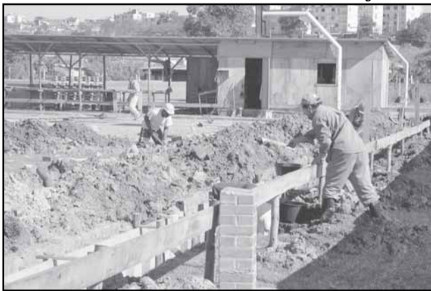
Obra do Centro de Reciclagem Tecnológica já tem fundações
