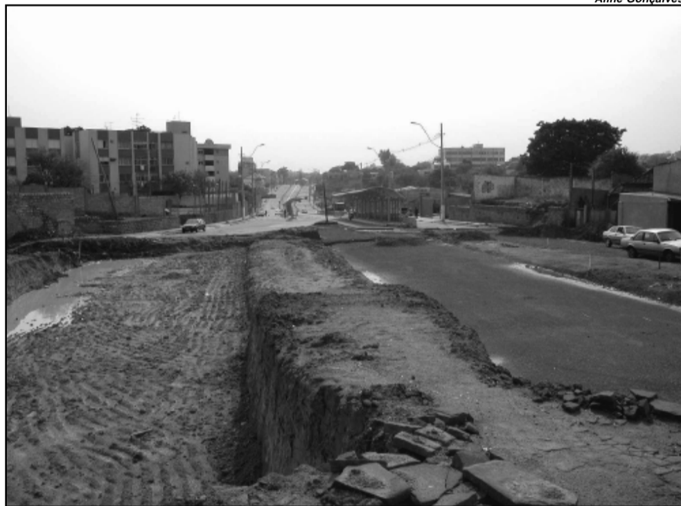
Terceira Perimetral: 85% das obras já estão concluídas
