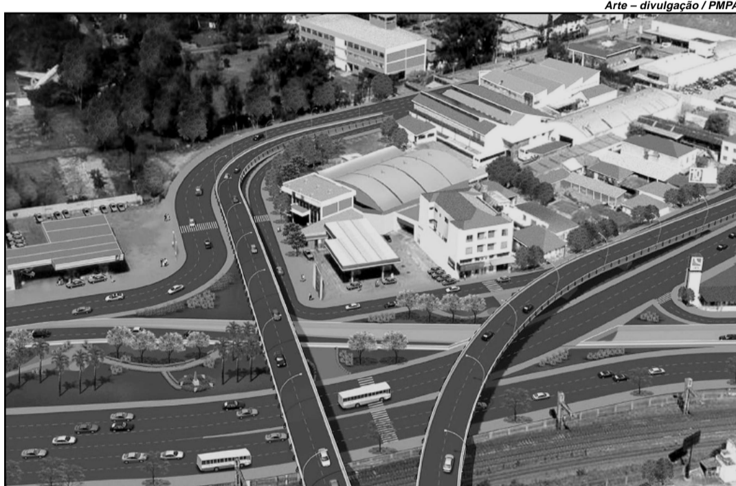
A altura do viaduto passará de 9 metros para aproximadamente 6,7 metros e manterá a largura de 8 metros
