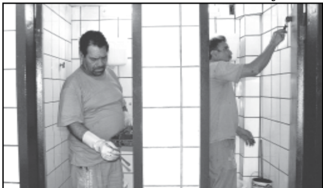
Reforma do sanitário da Praça Dom Feliciano será concluída em 10 dias
