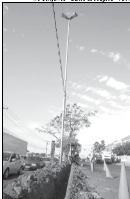
A primeira fase dos trabalhos compreende a abertura de valas para instalar a rede elétrica
