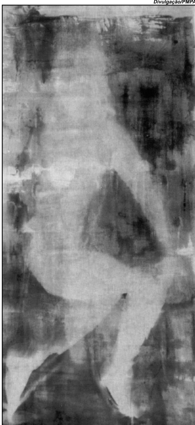
Técnica do início do século XX na Usina do Gasômetro
