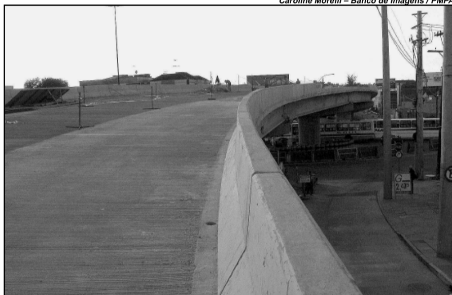
Viaduto da Benjamin Constant, uma das maiores obras em execução na cidade, terá liberação parcial amanhã
