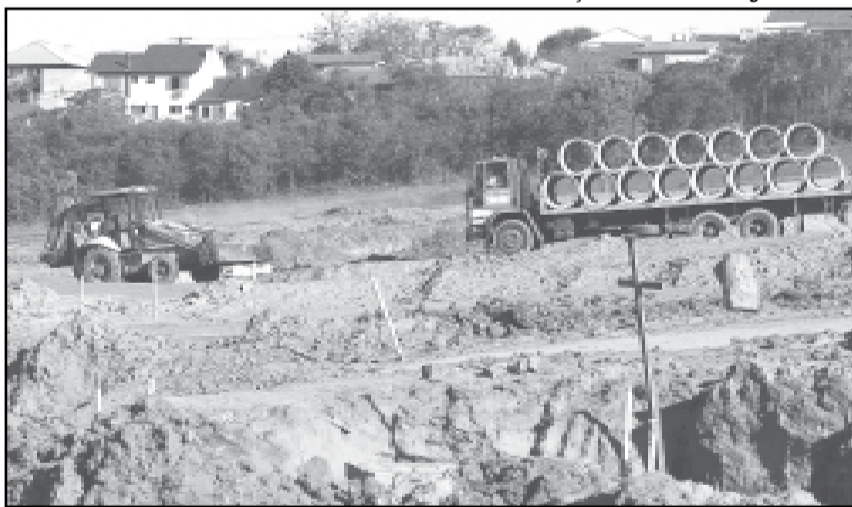
Quase metade das obras de infra-estrutura já foi concluída na área
