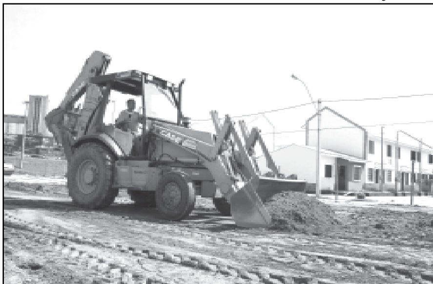
Primeira etapa da obra na Quadra A já começou
