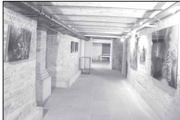
Projeto de climatização foi uma das medidas para o retorno ao Paço
