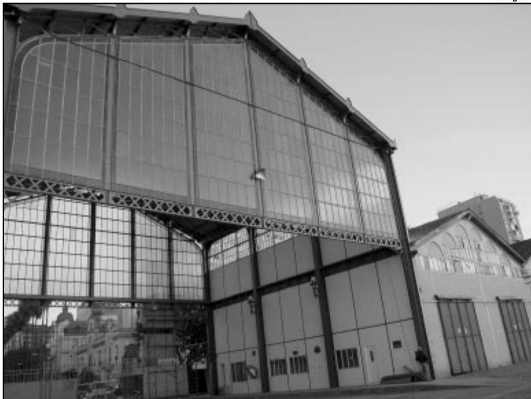
Pórtico Central do Cais do Porto foi restaurado com financiamento do programa
