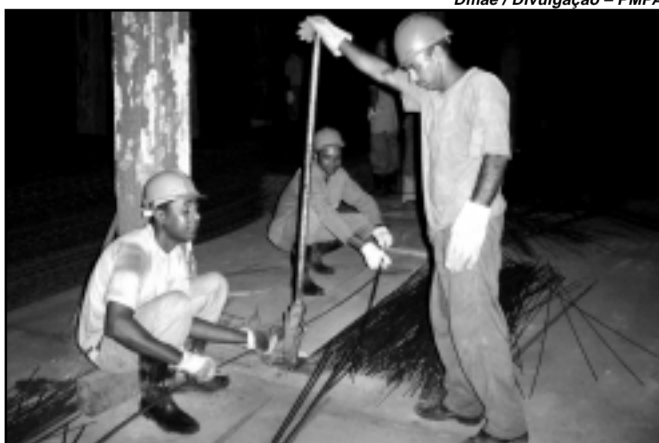
Operários trabalham no interior do reservatório para preparar a estrutura para concretagem
