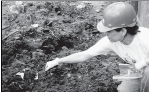
Há mais de 30 dias estudantes e profissionais trabalham no canteiro de obras
