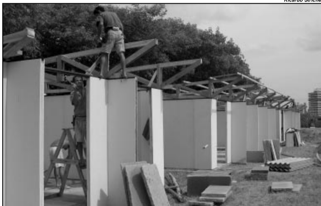
Obras para o encontro estão sendo executadas em vários pontos da cidade
