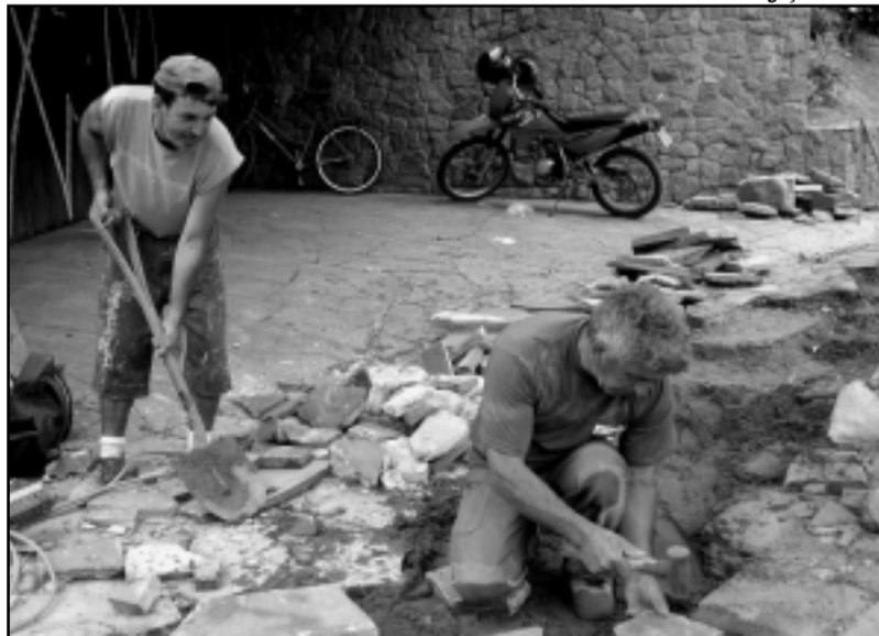
Na maior parte do bairro as obras já estão na fase final de repavimentação das calçadas
