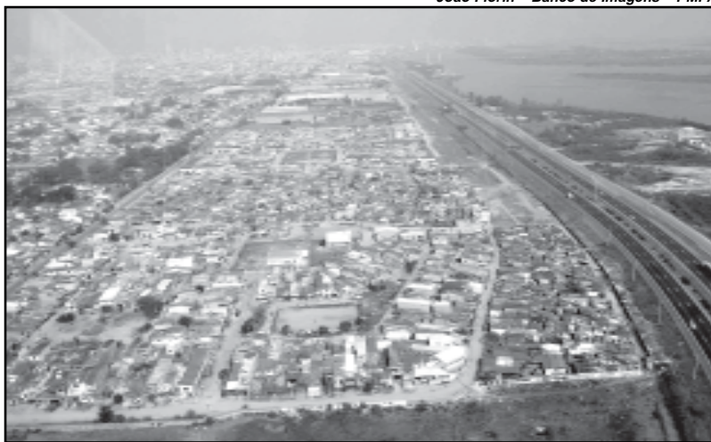
Investimentos públicos como o Piec promove a reestruturação urbana e a recuperação ambiental da Zona Norte
