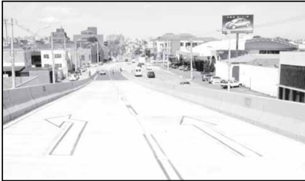
Foram investidos cerca de R$ 30 milhões na construção do viaduto e nas obras complementares
