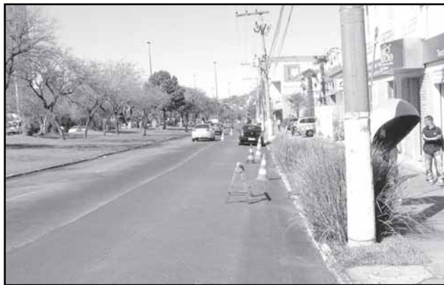
Pavimentação na Avenida Wenceslau Escobar
