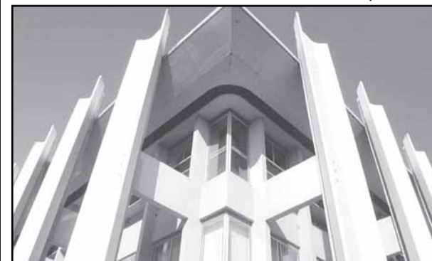
Fachada da CMPA
