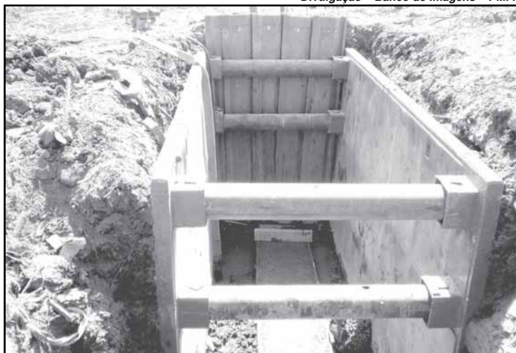
Obras do Dmae beneficiam moradores da Capital
