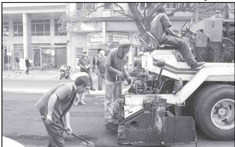
Os trabalhos integram a segunda etapa do Programa de Revitalização Asfáltica
