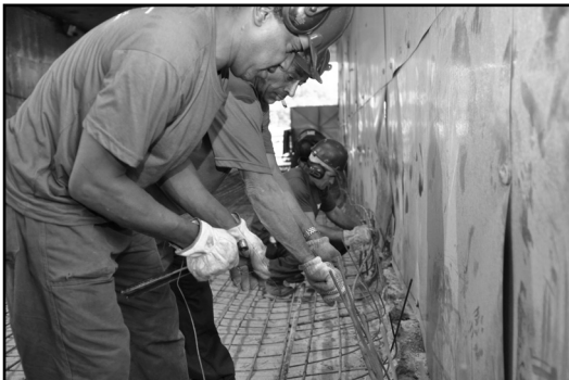
Montagem das armaduras da nova laje já foram concluídas
