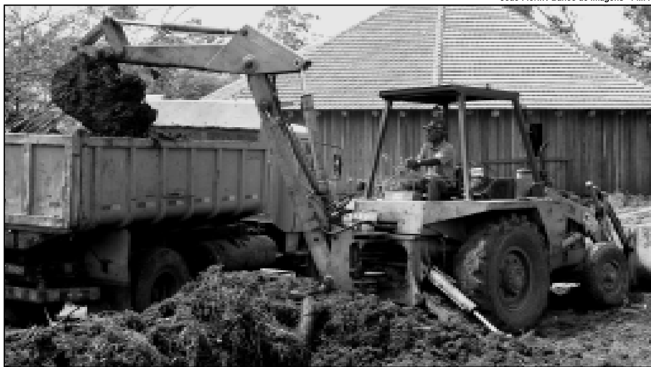
Obras de saneamento básico e estrutura viária foram concluídas
