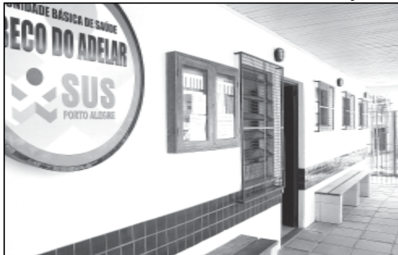
Desde outubro do ano passado 31 postos já foram reformados
