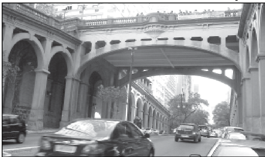
Viaduto Otávio Rocha, na Borges de Medeiros, é uma das atrações do roteiro de sábado
