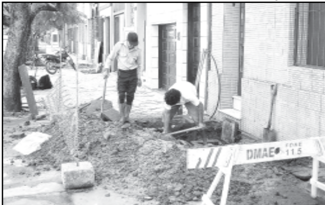
A substituição de 20km de rede de água no Bairro Cidade Baixa foi realizada no segundo semestre de 2007
