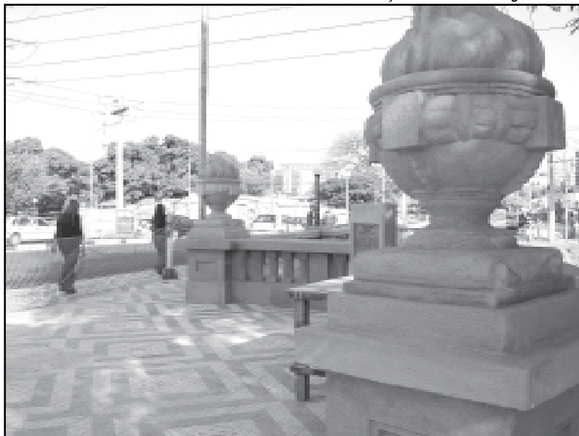
Os trabalhos estão concentrados na finalização da colocação de ladrilhos nos passeios públicos
