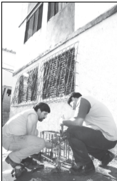
No ano passado, foram instalados 1,7 mil novos hidrômetros
