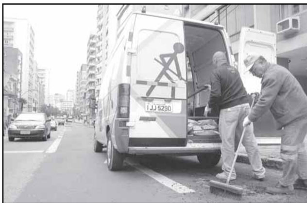
Equipe identifica problemas e realiza reparo imediato
