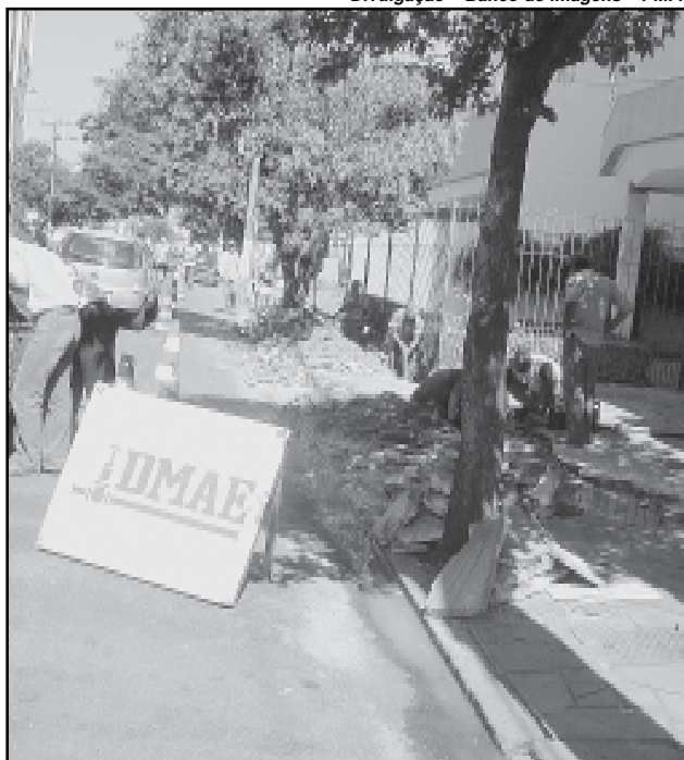
Avaliada em R$ 3,7 milhões, a obra iniciou em novembro de 2005
