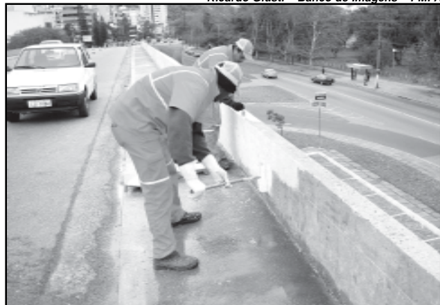
DMLU formou equipe para trabalhar na revitalização dos viadutos
