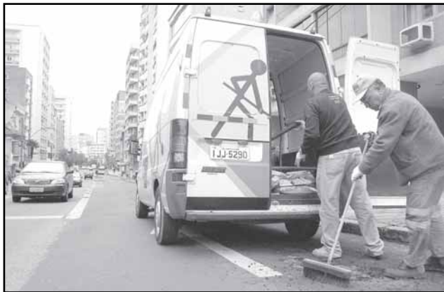
Equipe identifica problemas e realiza reparo imediato
