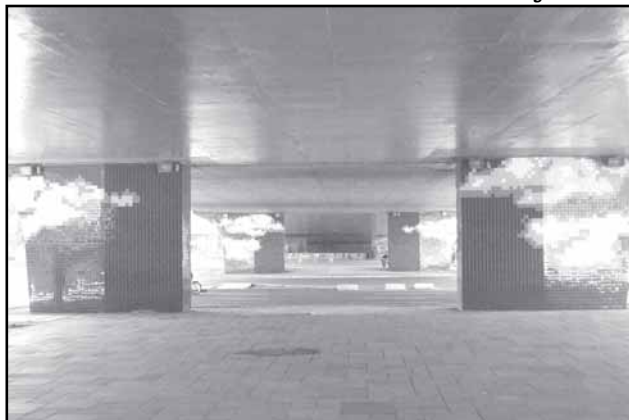
A obra de Zoé Degani está instalada no viaduto da João Pessoa
