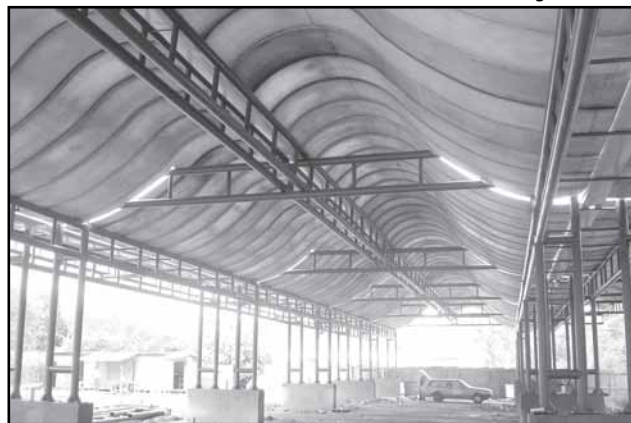
Estruturas foram reaproveitadas dos terminais da Praça Rui Barbosa
