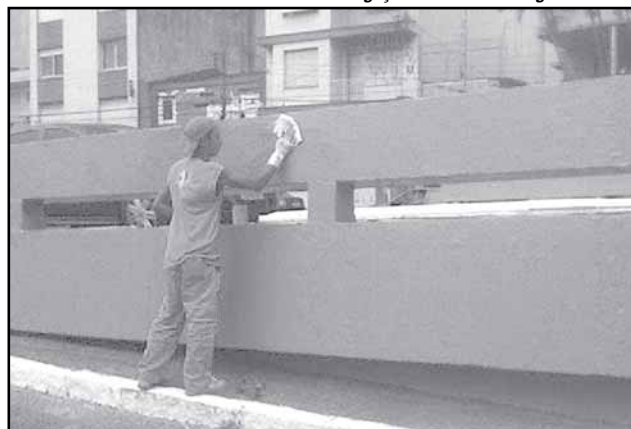
Desde 2007, equipe do DMLU protegeu oito viadutos com tinta especial
