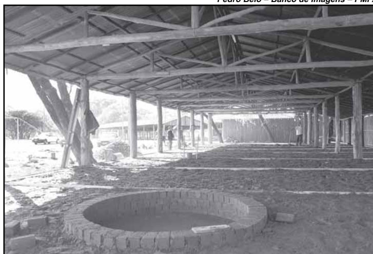
Galpões fixos começam a tomar forma no Parque da Harmonia
