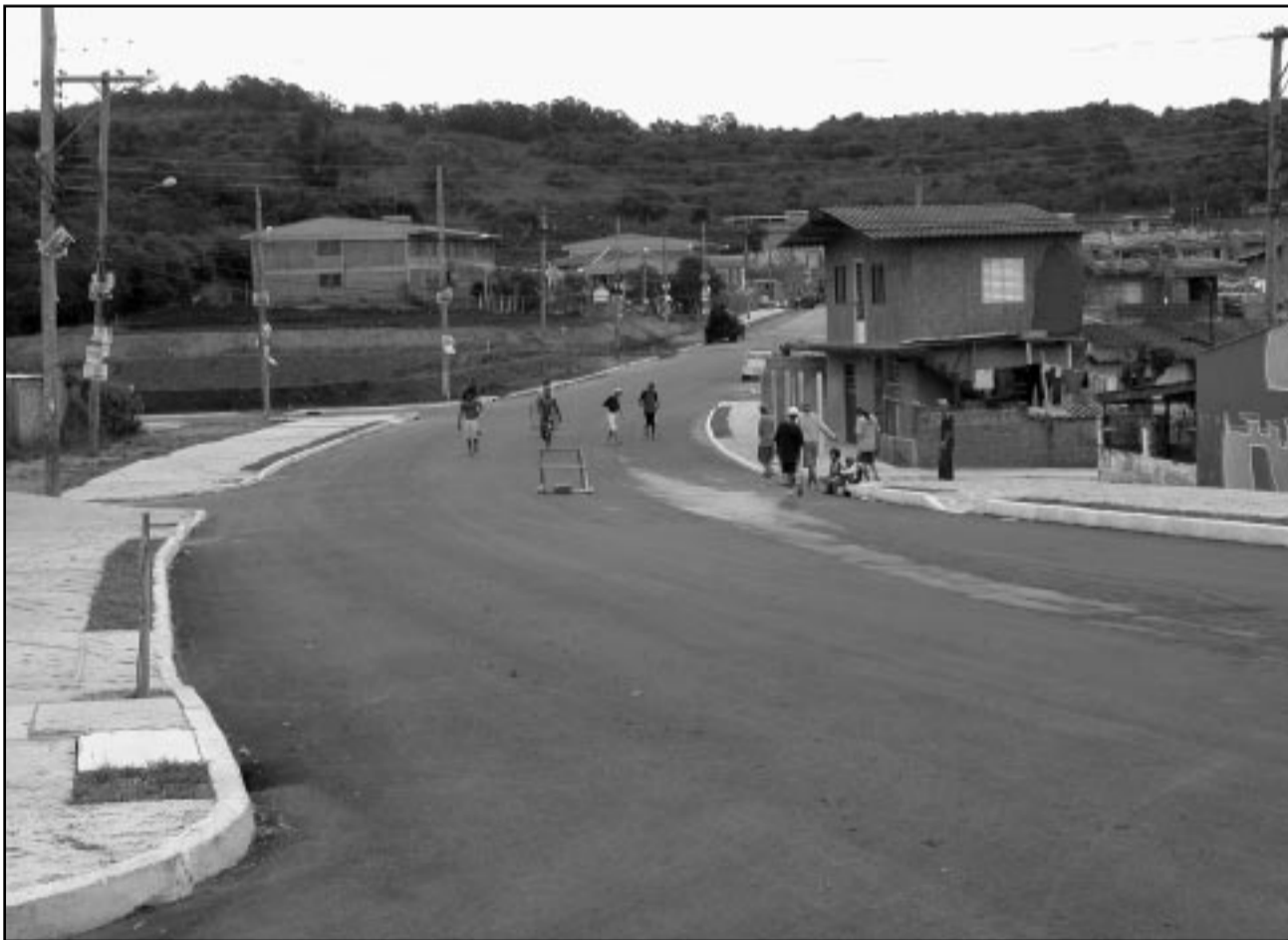
Trabalho incluiu a pavimentação de 18 ruas, com execução de calçadas
