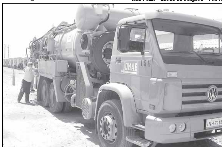
Caminhão vai auxiliar na retirada de entulhos das tubulações
