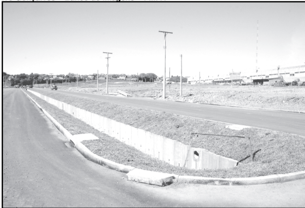
Obras de infra-estrutura e construção das casas somam R$ 56,5 milhões
