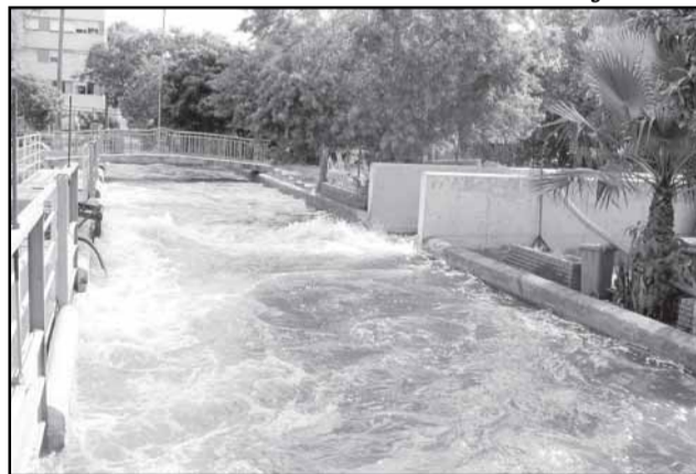
Chegada da água bruta na Estação de Tratamento Moinhos de Vento
