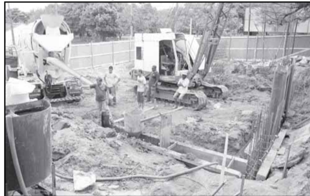
Casa de Bombas Santa Terezinha está em construção e terá 361m 2
