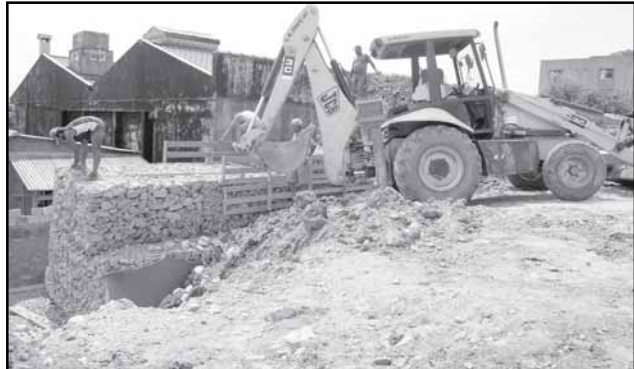
Terreno das novas casas da Vila Chocolatão já está sendo preparado
