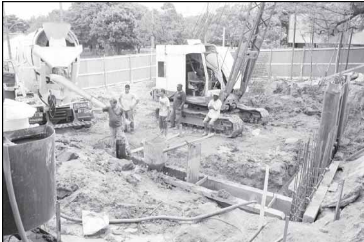
Primeiro e segundo lotes iniciaram as escavações na segunda
