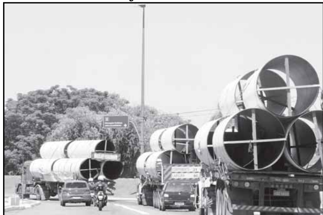
Caminhões transportaram os canos até a Beira-Rio, onde foram descarregados
