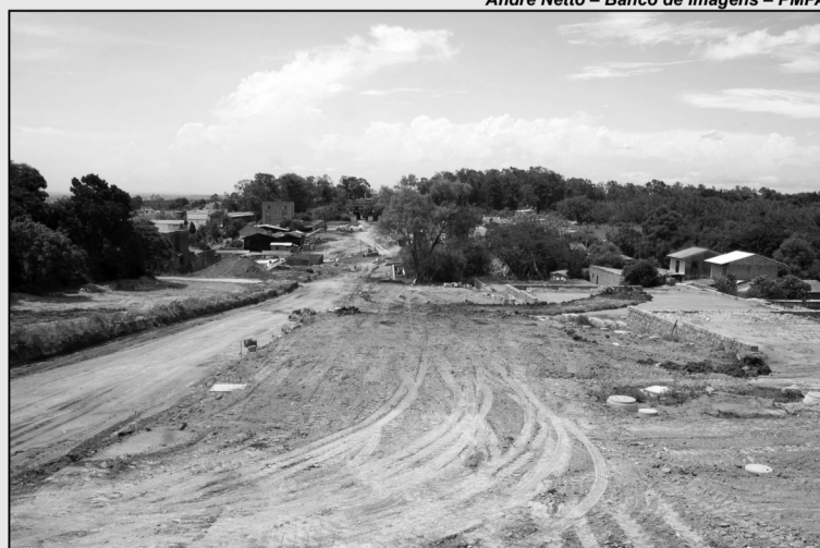
As casas serão construídas em terreno de 33 hectares que recebe obras de infraestrutura
