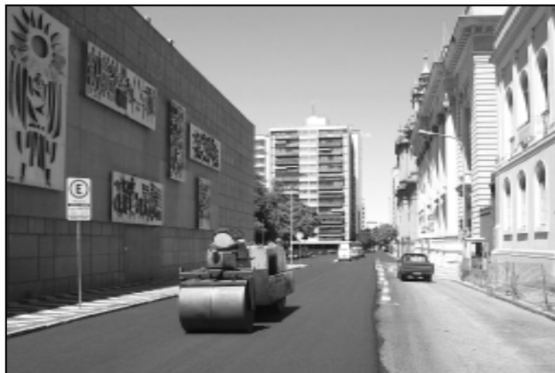
Operários trabalharam na Rua Duque de Caxias durante o final de semana
