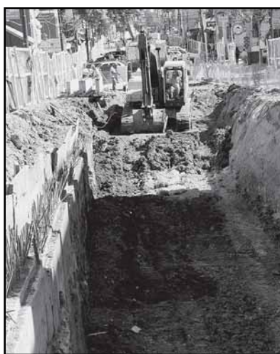
Entre as ruas Bordini e Mata Bacelar estão sendo realizadas as escavações com aproximadamente 12 metros
