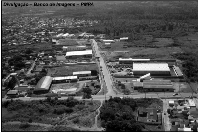
Parque Industrial da Restinga entra na segunda fase de ampliação
