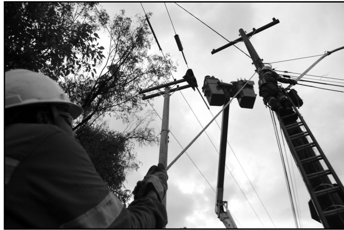
Previsão é de que as próximas intervenções sejam executadas em até 20 dias
