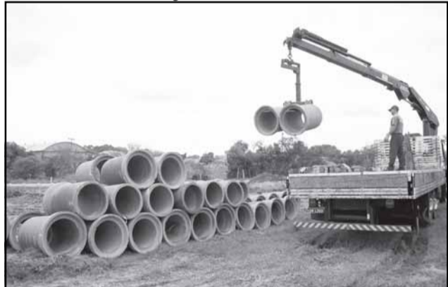
As obras estão na fase de infraestrutura
