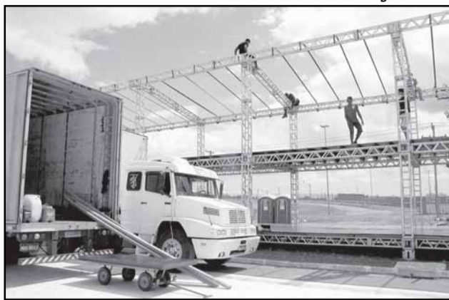
Ritmo acelerado na montagem das arquibancadas
