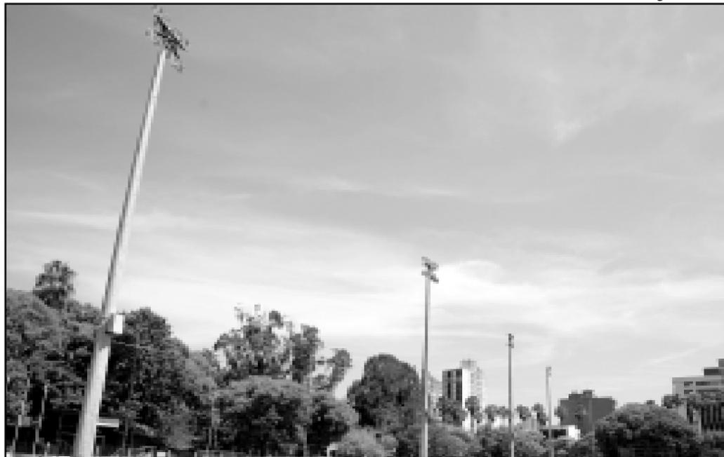
Campo recebeu oito postes com projetores com lâmpadas de vapor metálico
