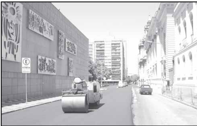
Obras de pavimentação na Rua Duque de Caxias
