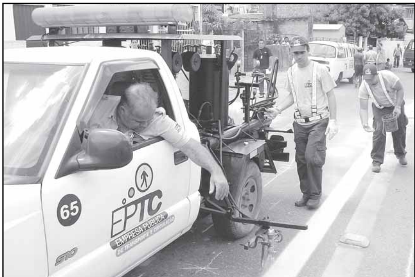
Pintura da pista, instalação de placas e tachões
