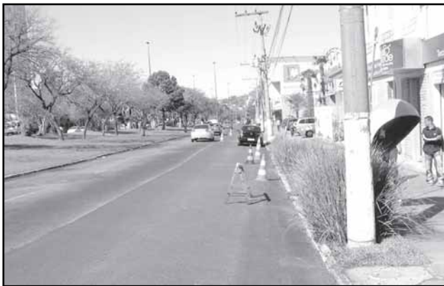
Pavimentação na Avenida Wenceslau Escobar
