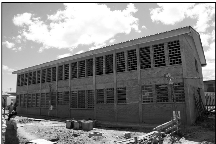
Primeira parte das construções estará finalizada até março
