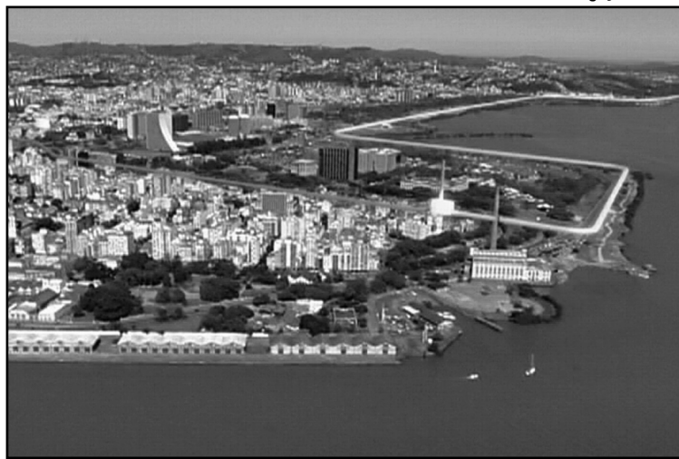
Porto Alegre terá capacidade para tratar 77% do esgoto
