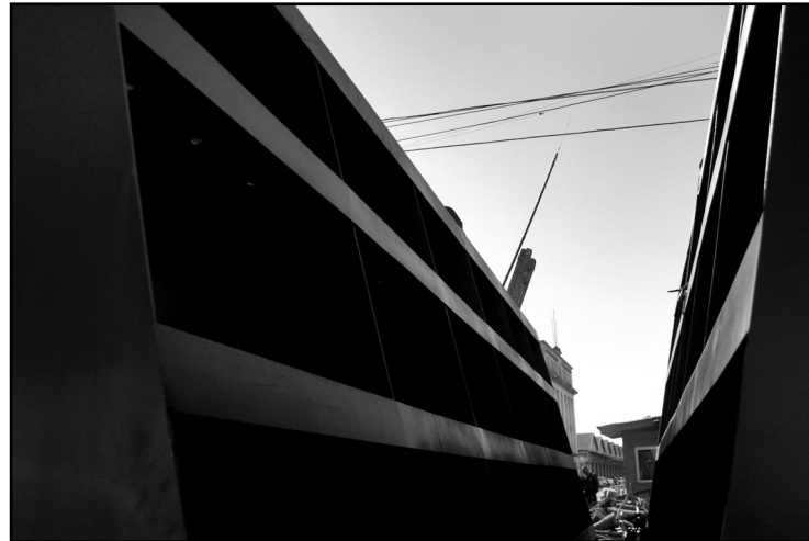
Portões têm acionamento hidráulico
