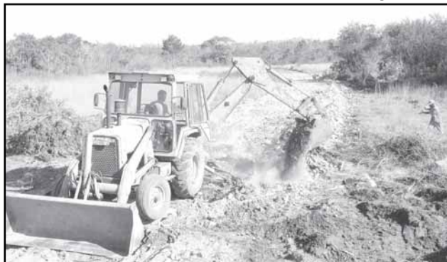
Obras de infraestrutura foram concluídas em abril
