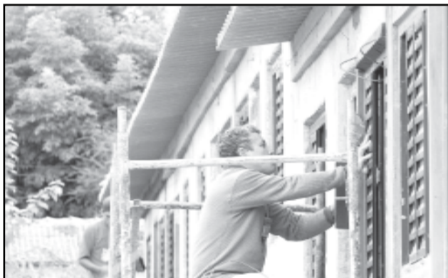
Obra na Cristiano Kraemer (Residencial São Rafael)
