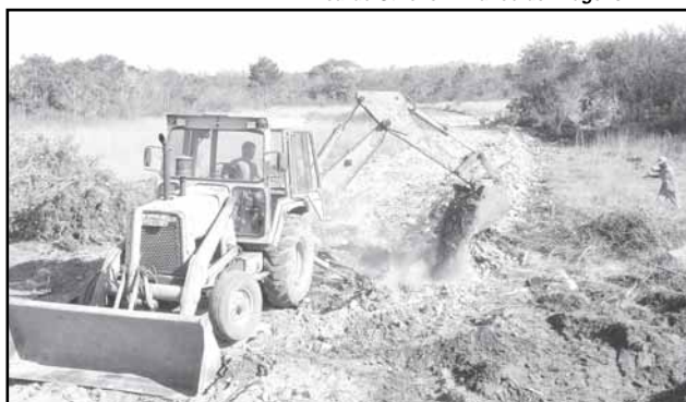
Obras de infraestrutura foram concluídas em abril
