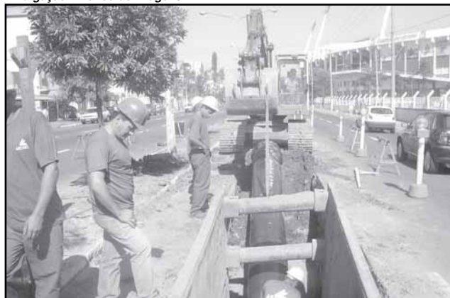
A obra recebe investimento de R$ 2,7 milhões e deve estar concluída em setembro
