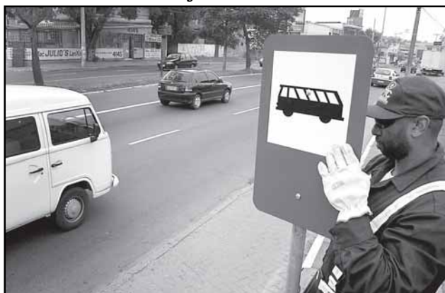
Foram instaladas placas de orientação, proibição e parada de ônibus
