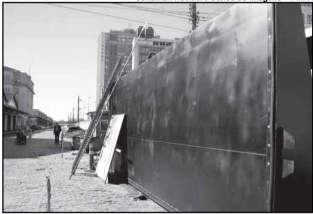
Acionamento hidráulico permitirá fechamento do portão em 50 segundos
