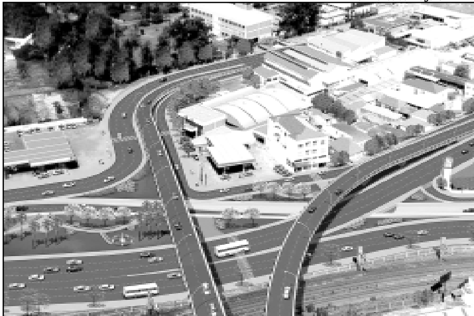
O Viaduto Leonel Brizola fará a ligação da Terceira Perimetral à BR-290 passando pelo bairro Humaitá, proporcionando a revitalização do bairro
