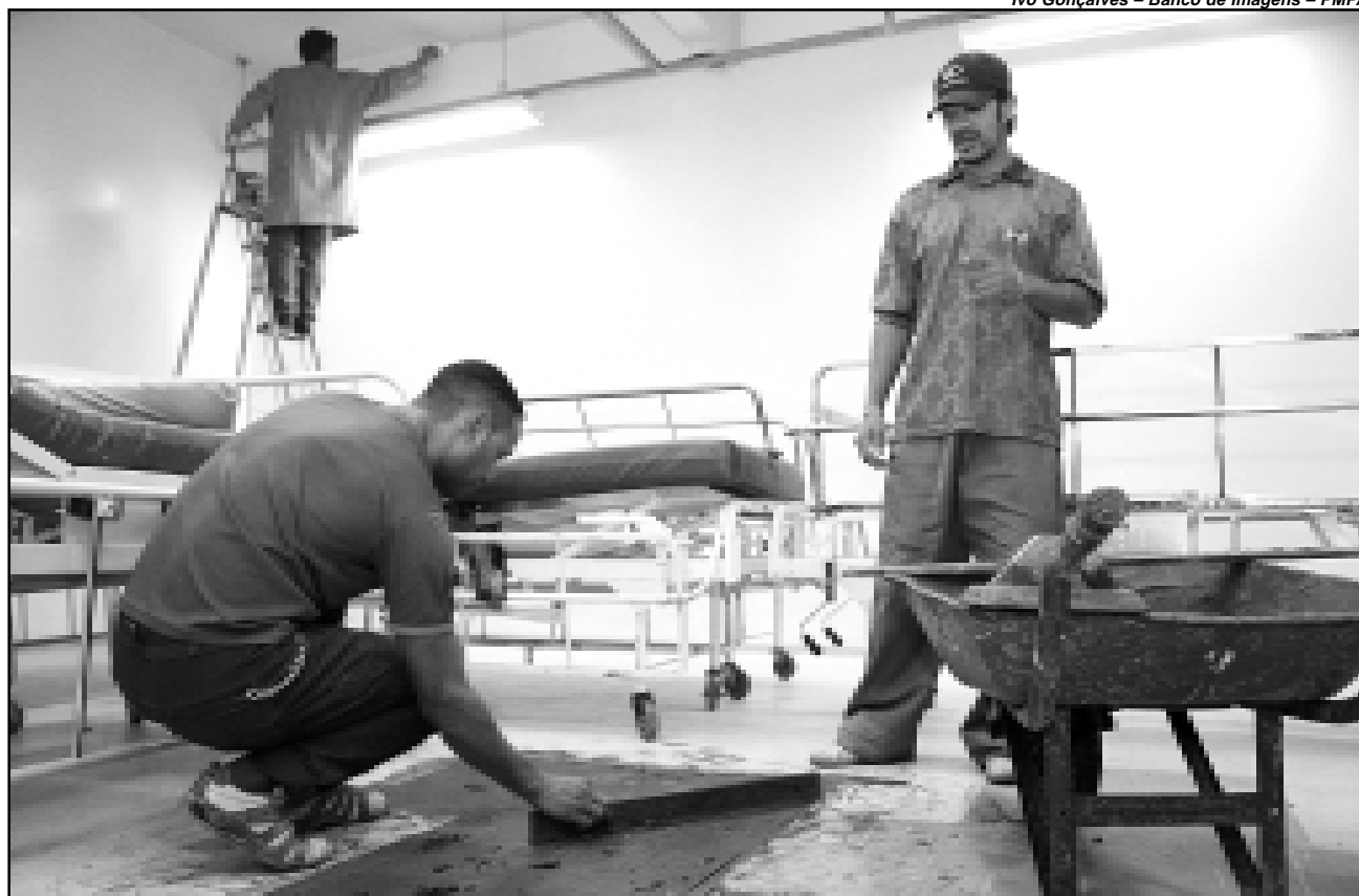
Obras estão sendo feitas em ritmo acelerado
